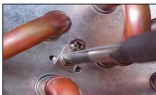
Ejemplo de sujeción. brida inox al lateral de la batería. Sólo por un extremo
